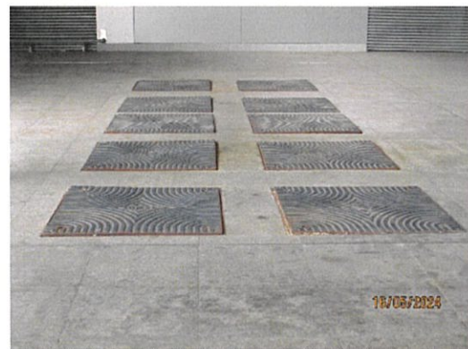
ภาพถ่ายที่ 2.2-12 บ่อดักน้ำมันและไขมัน
